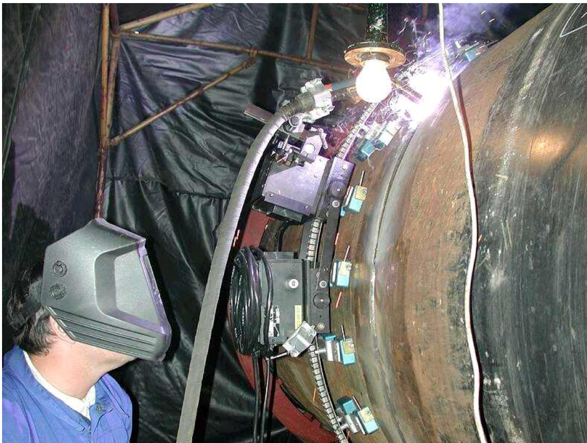
1. ábra: MAG orbitális berendezés üzem közben
