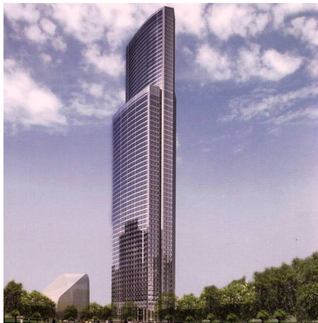
1.kép: Eurasia Toronyépület Moszkvában (jelenleg építés alatt) [1]
